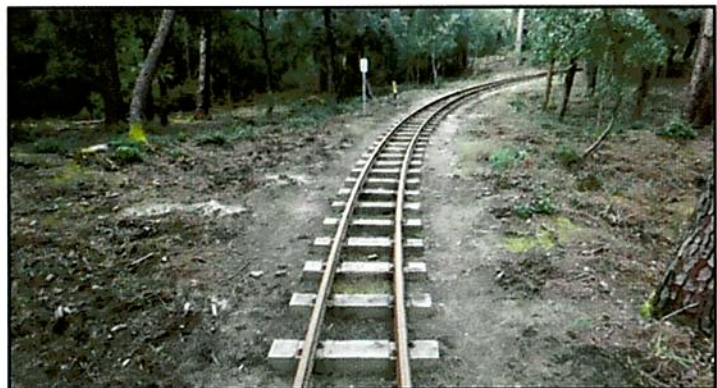
St Trojan – La section de voie renouvelée avec traverses bois. Tous clichés A. Blondin
